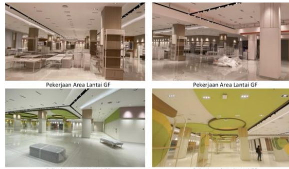
Gambar 3 Foto Pekerjaan Proyek Tahap 1 (Pembongkaran dan Pemasangan Konstruksi Rangka baru) di STAR Retail Department Store Summarecon Bekasi, Sumber: Tim Proyek Summarecon Bekasi, 2024.
