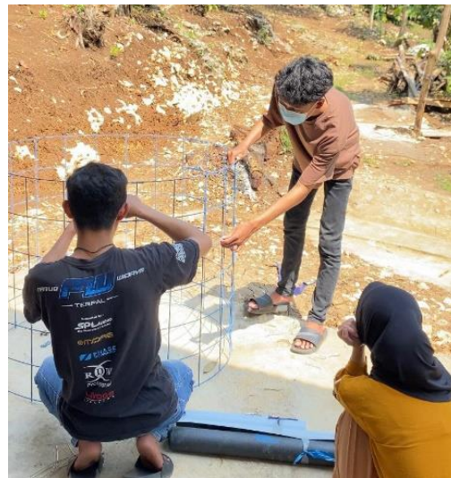
Gambar 7. Perakitan Rangka Besi Kolam Akuaponik
