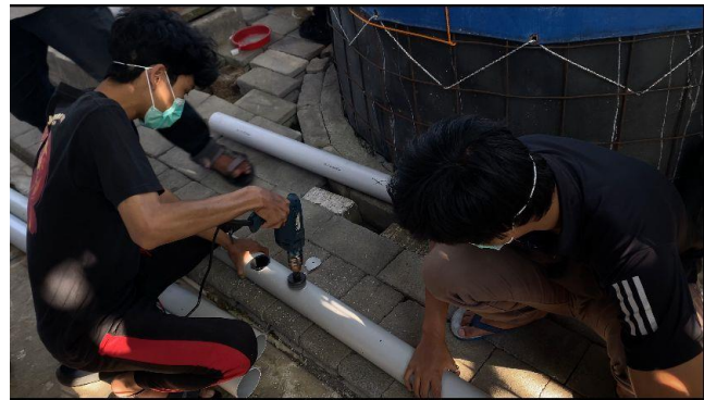
Gambar 14. Pelubangan Pipa Akuaponik
