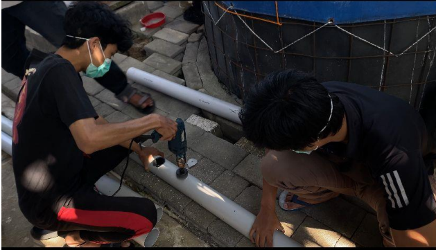
Gambar 8. Pemasangan Pipa Pembuangan Air
